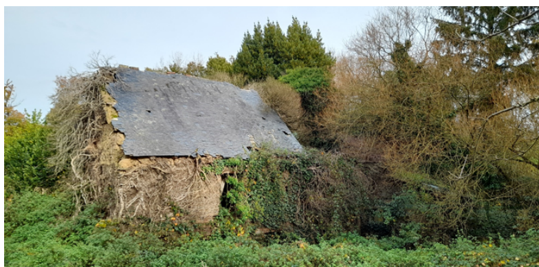
Bâtiment dégradé situé au lieu-dit La Planche
